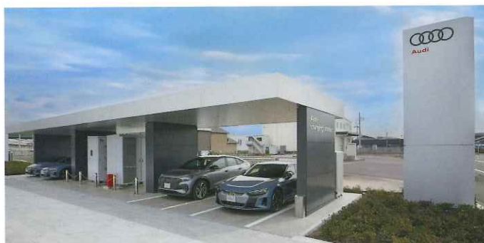
電気自動車の急速充電サービスを提供する「Audi charging station 厚木」
