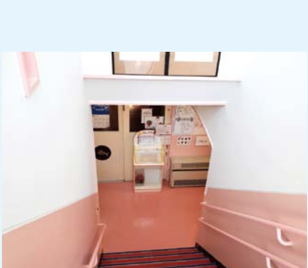
施工例(いその保育園)
