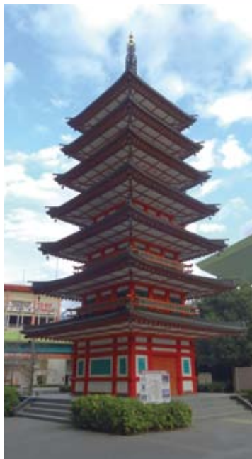
実物の1／3に復元された七重の塔
