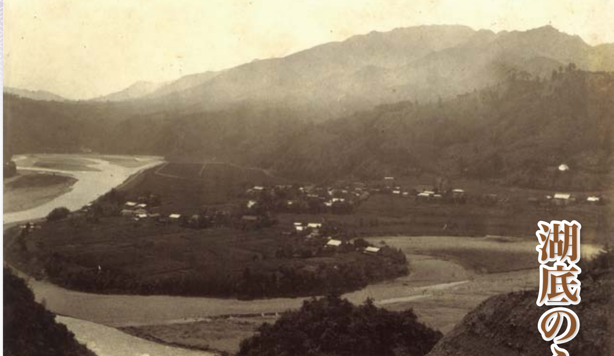
相模湖町橋沢より望む勝瀬の全景
