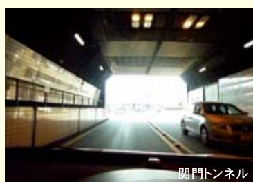
関門トンネル
